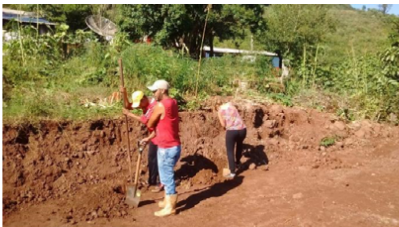
Figura 5 - Momento da abertura das covas para colocar os postes que dariam sustentação à estufa
