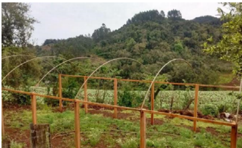
Figura 8 - Estrutura da estufa sem a cobertura
