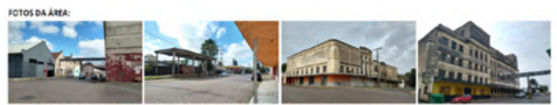
Figura 139 - Fotos das estruturas existentes na cidade
