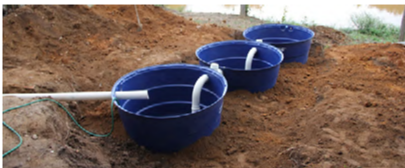
Figura 132 - Foto demonstrativa de um sistema de fossa biodigestora
