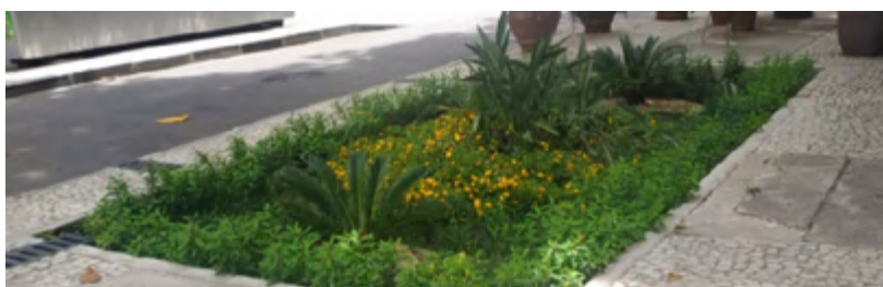
Figura 136 - Foto demonstrativa de um sistema de biorretenção
